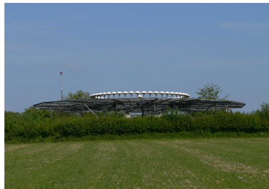
〈그림 3-4-3-2〉 왼쪽 : DME 안테나, 오른쪽 : VOR에 DME를 같이 시설한 모습
